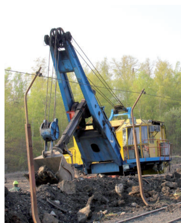
Lopatová rýpadla pomáhají při zakládání materiálu s velkým množstvím cizích předmětů. Foto: (pim)
