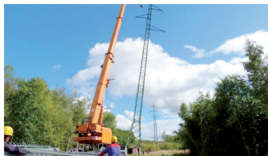
Postavit bylo třeba sedm stožárů velmi vysokého napětí. Foto: (paš)
