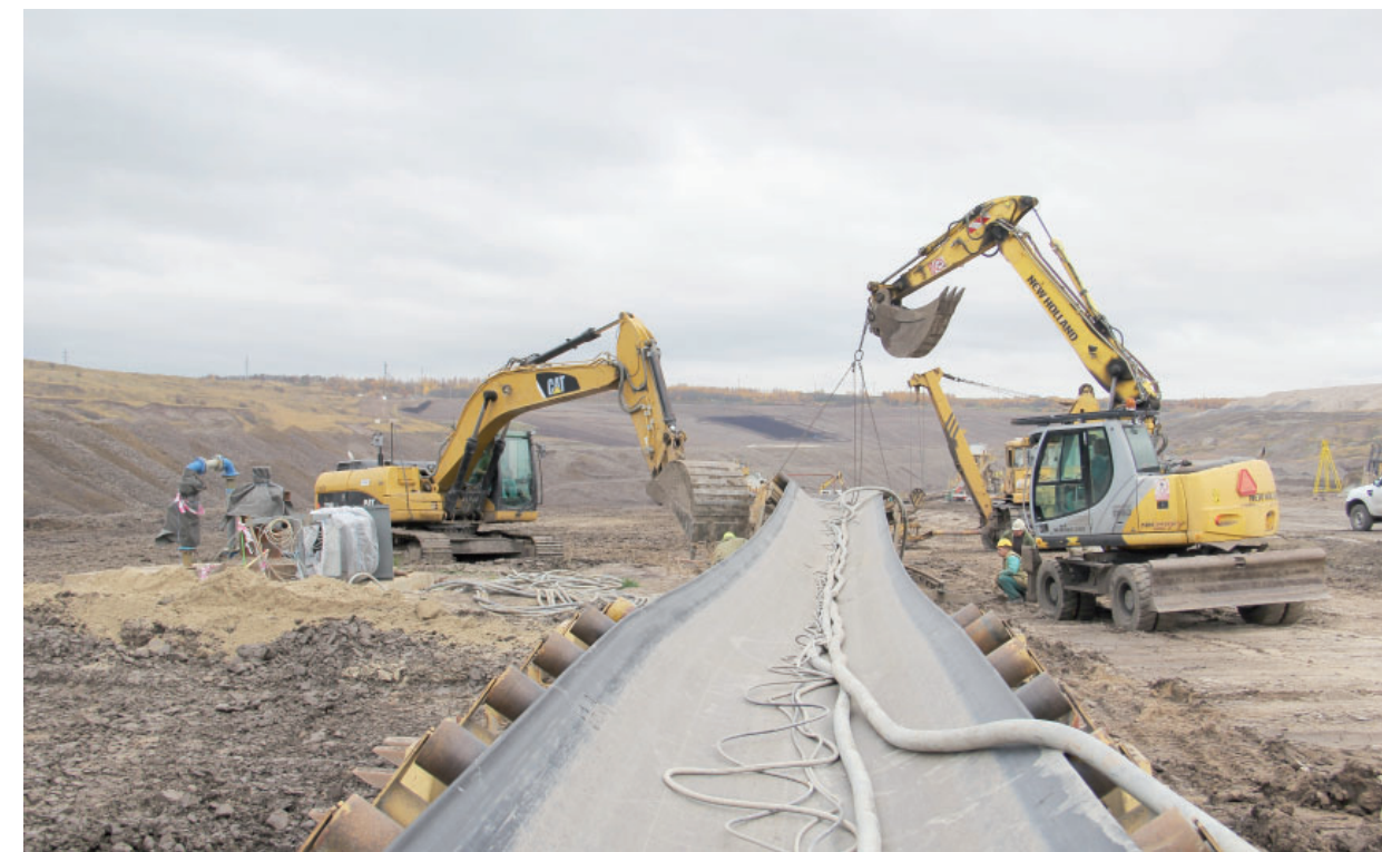
Přestavbáři zvládli přenést dopravníkovou linku přes vrt STE8 během jedné směny. Foto: (pim)
