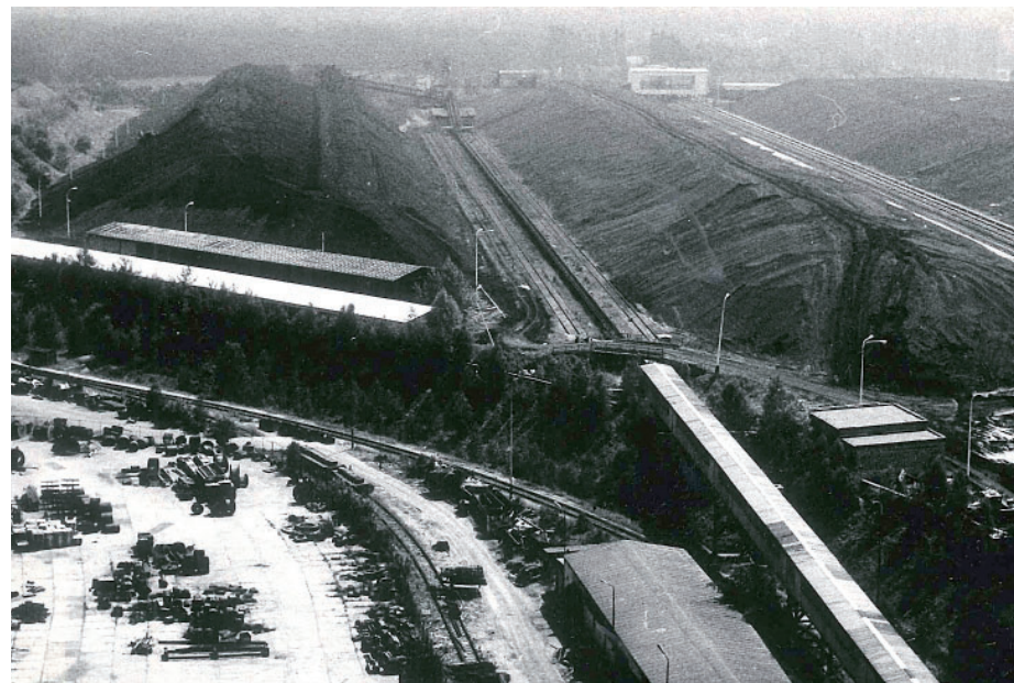
Skládku paliva ve Chvaleticích měla kapacitu až milion tun uhlí. Foto: Archiv Sev.en EC
