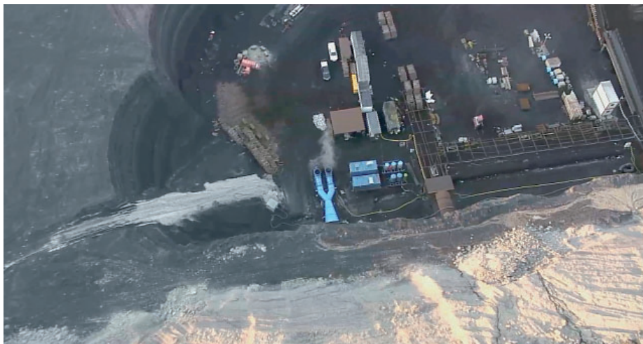
Na první pohled to vypadá jako obyčejný snímek z výšky lomu ČSA. Jedná se ale o záběr z dronu zachycující pracoviště hlubinařů před vstupem do chodbic ve svazích lomu.
