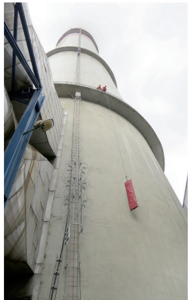
Na ochoz elektrárenského komína bylo potřeba vytáhnout i nosítky pro zraněného.
