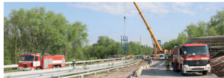
Stavba trubního mostu probíhala za mimořádných bezpečnostních opatření. Foto: (pim)
