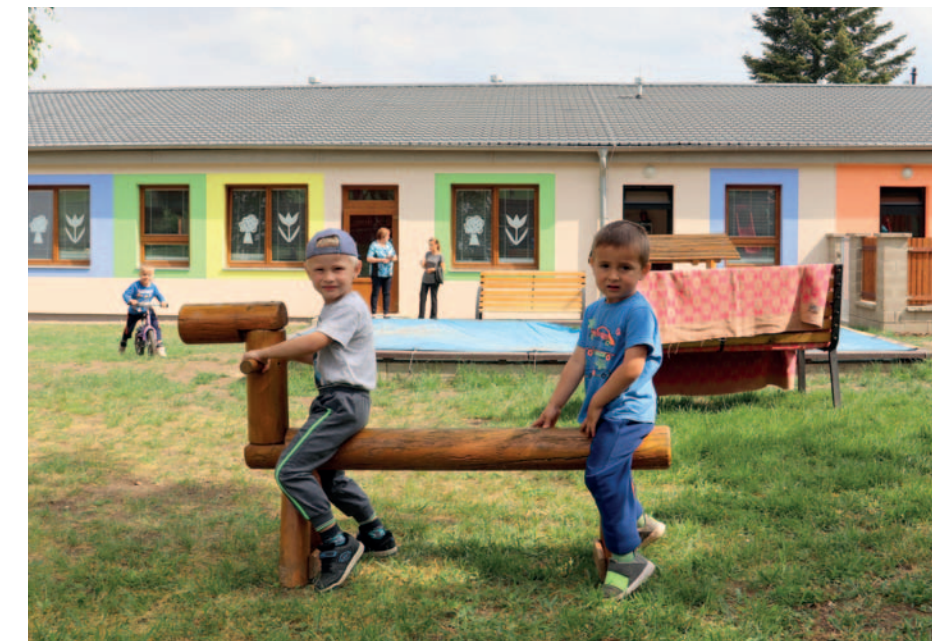
Objekt mateřské školy v Havrani prošel kompletní rekonstrukcí. Foto: (pim)
