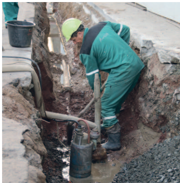
Nové potrubí se pokládá přímo před sídlem úseku skrývky v lokalitě Vršany. Foto: (pim)
