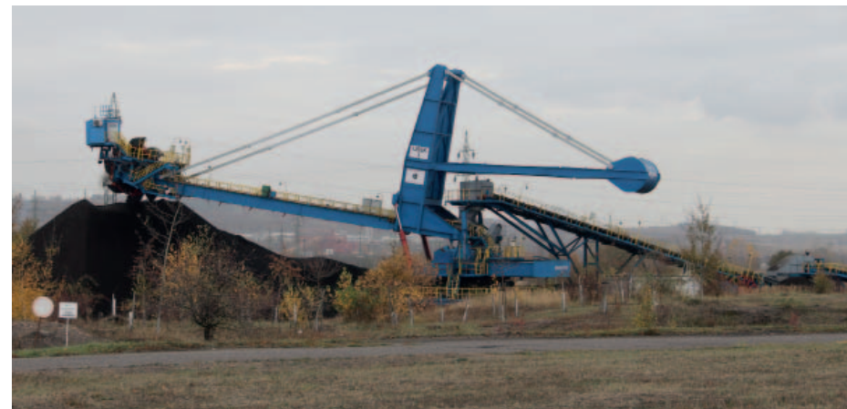
Na podzim se vrátil po opravě zpět do provozu ve Vršanech skládkový stroj USSK1. Foto: Archiv DN
