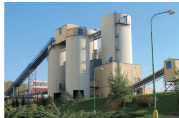
Míchací centrum. Místo, kde se vyrábí stabilizát. Foto: Sev.en EC
