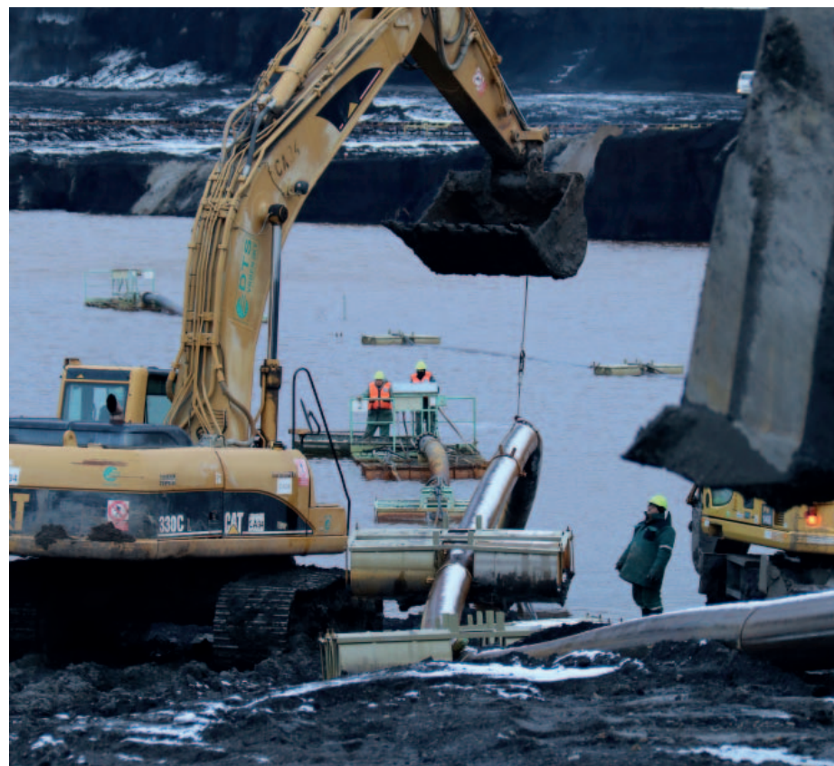
Spojil obě vertikální čerpadla bylo potřeba přímo na hladině jímky hlavní čerpací stanice lomu ČSA. Foto: (pim)
