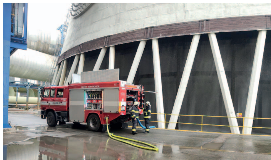
Čerpací stanoviště u chladicí věže č. 4.
